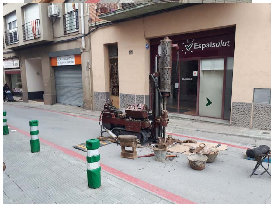
Fotografies de la sonda rotativa durant els treballs del sondeig S-2 davant del núm. 75 del carrer del Padró.
