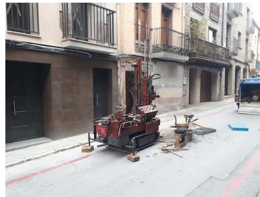
Fotografies de l'emplaçament de la sonda rotativa en el punt de sondeig S-1 en un tram d'estudi del carrer Padró de Sant Fruitós del Bages .
